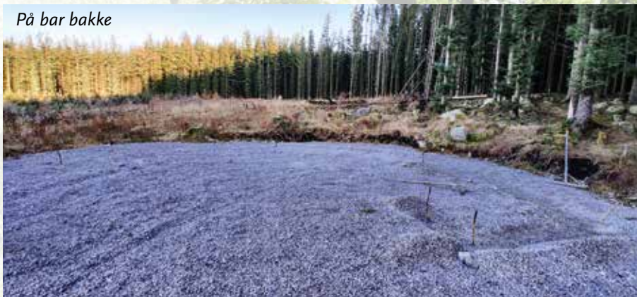
Forskaling til grunnmuren
